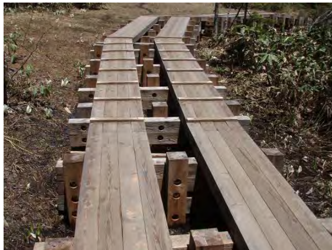
木道の高さを確保するため枕木を重ねて設置した事例
