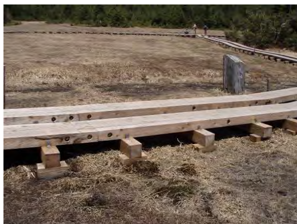
高さ調整のため枕木の下に角材を設置 (尾瀬沼)
