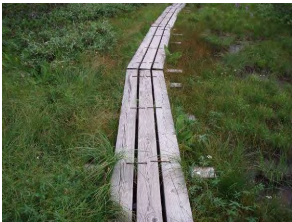
枕木+床板 (大雪山沼の平) 床板の幅を狭くし隙間をあけて設置する
