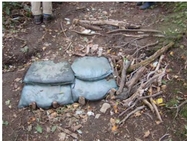
土嚢を利用したステップ
