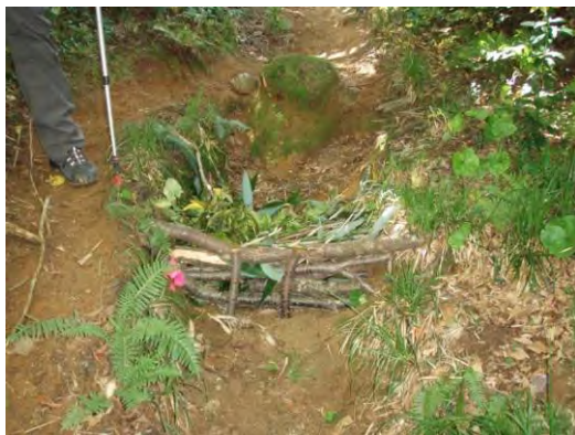
樹枝を利用した土留工 (背後に葉を詰める)
