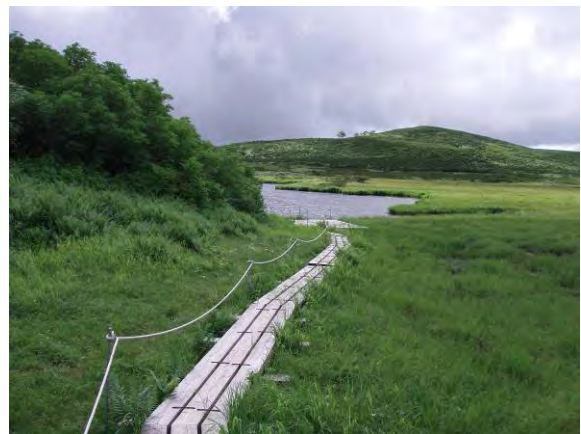
枕木+床板 (大雪山沼の平) 床板の幅を狭くし隙間をあけて設置する
