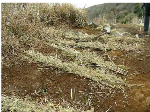
樹枝やササを束ねてつくる土留工
