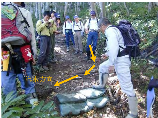
樹枝と土嚢袋を利用した分散排水工 (羅臼岳登山道)
