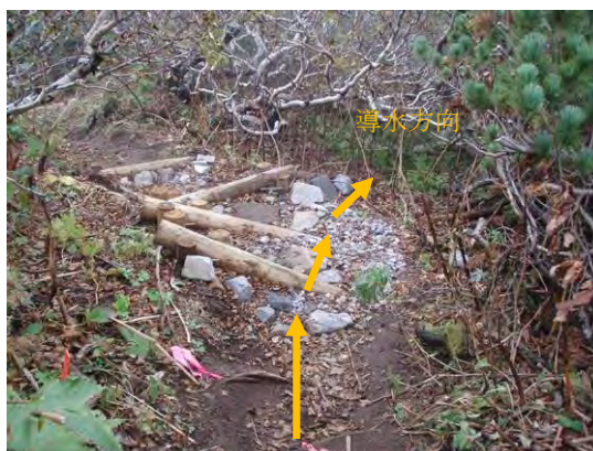
丸太を利用した分散排水工 (利尻岳登山道)
