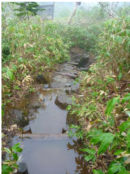
歩道の浸食が進んでいる
