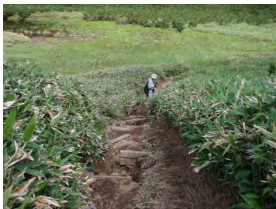
洗掘された階段部から二の沼方向
