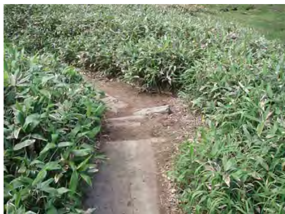
三の沼側の木道が流出土砂の土留となっている
