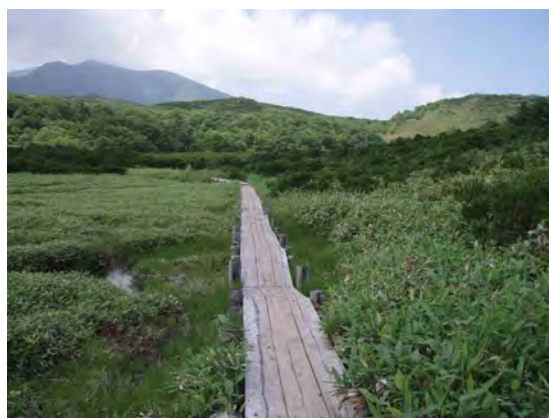
湿地部では木道が沈下しやすい
