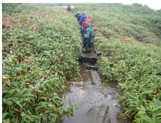
歩道階段部を流下する水の状態
