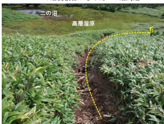
土砂を浸食しながら歩道階段部を水が流下
