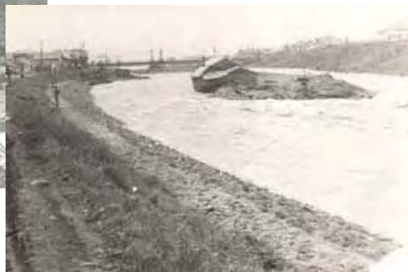
羅臼川河口付近の被害状況
