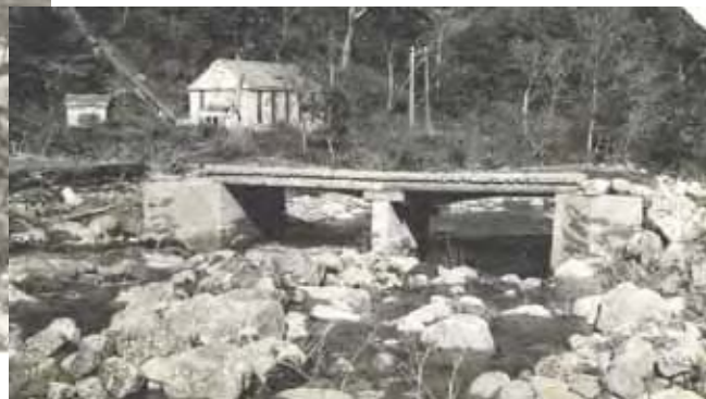
発電所付近の被害状況
