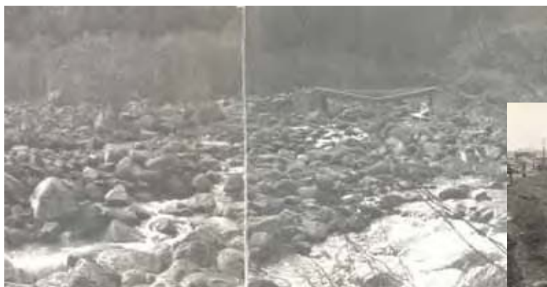
湯元橋付近の被害状況
