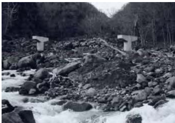
現在の知床大橋付近の被害状況
