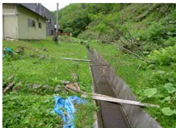
水路工の状況。V型トラ7600mm使用。
