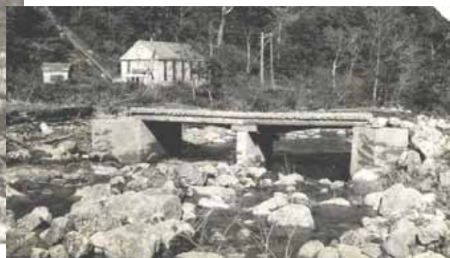
発電所付近の被害状況
