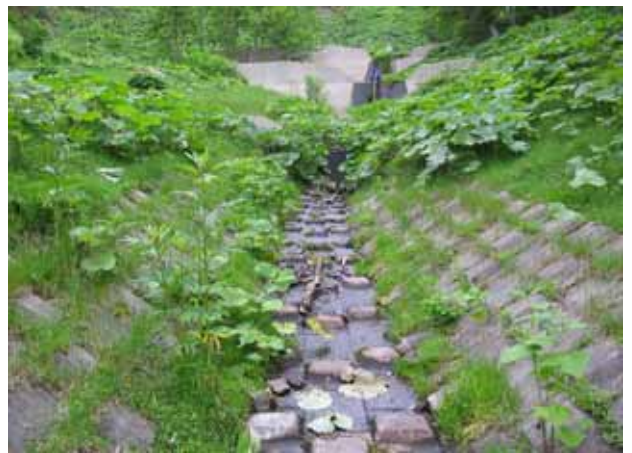
上流のブロック三面張り水路工の状況。
