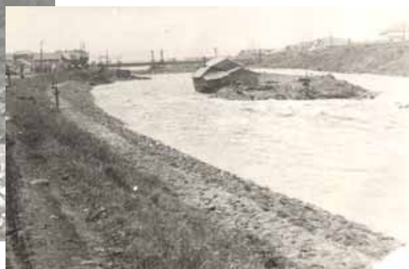
羅臼川河口付近の被害状況
