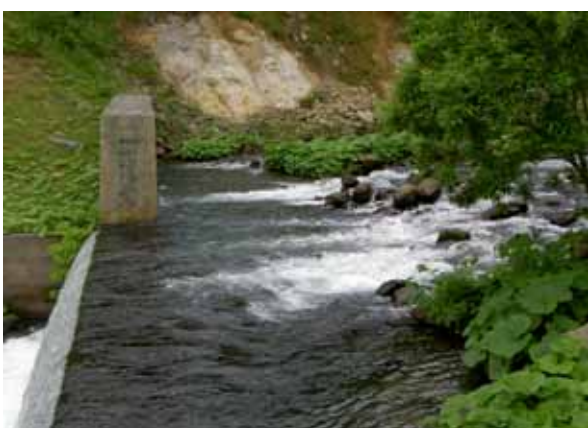
上流の土砂堆砂状況。
