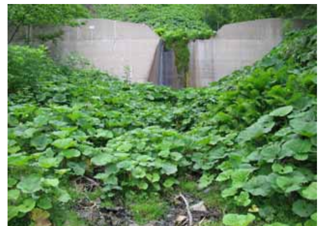
上流の土砂堆砂状況。
