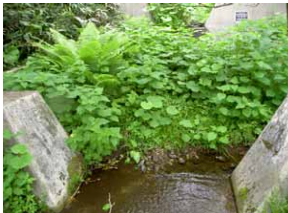
上流の土砂堆砂状況。
