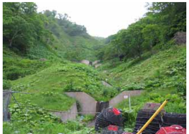
落差工の全体配置状況。
