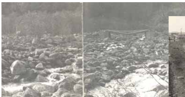
湯元橋付近の被害状況
