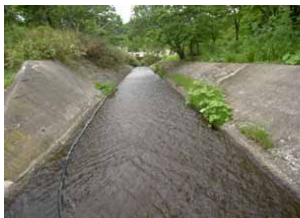
三面張水路工内の状況。
