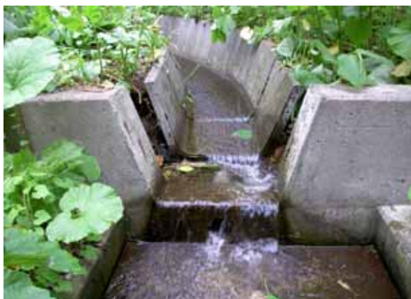
水路工起点の落差工(落差0.25m)。
