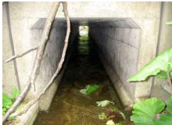
ボックスカルバート内の状況。
