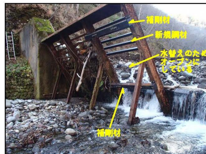
先行事例（オッカバケ川2号ダムの切下げ時のスリット部部の状況）
