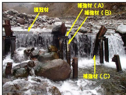
先行事例（オッカバケ川2号ダムの切下げ時のスリット部の状況）
