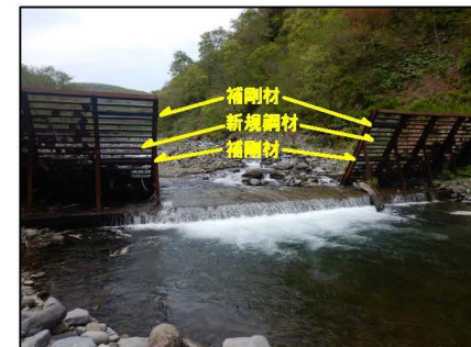
先行事例（オッカバケ川2号ダムの切下げ終了後の状況）
