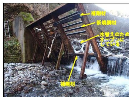
先行事例（オッカバケ川2号ダムの切下げ時のスリット端部の状況）
