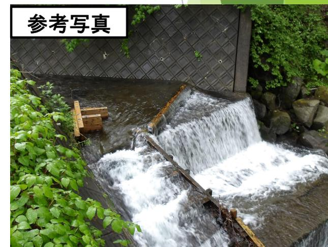
イワウベツ川盤ノ川における木材を利用した流水の引き込み
