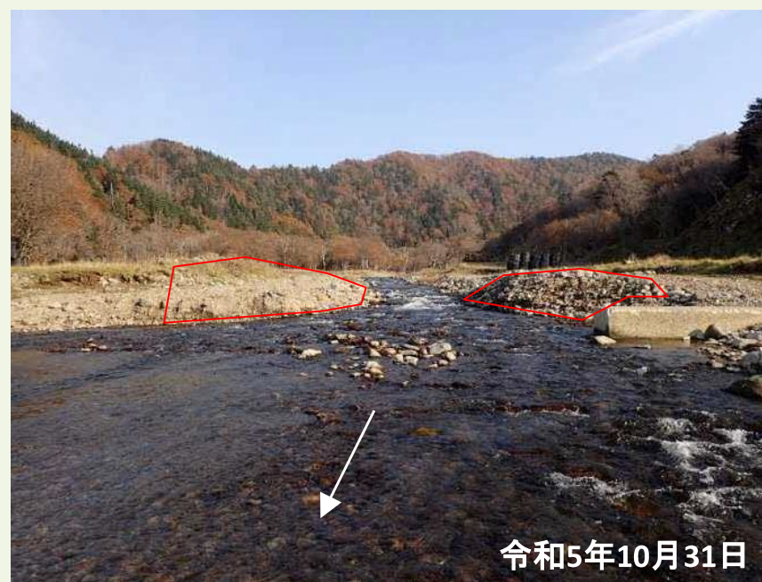
第1ダム＋5～20m地点(下流側から)
