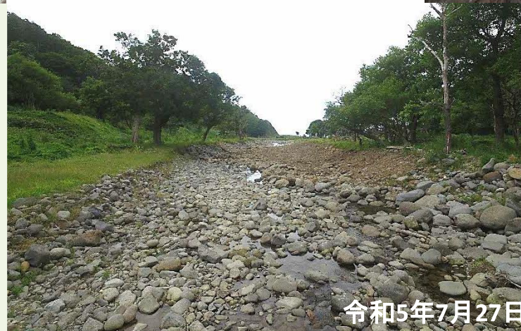
施行後(通水前)
