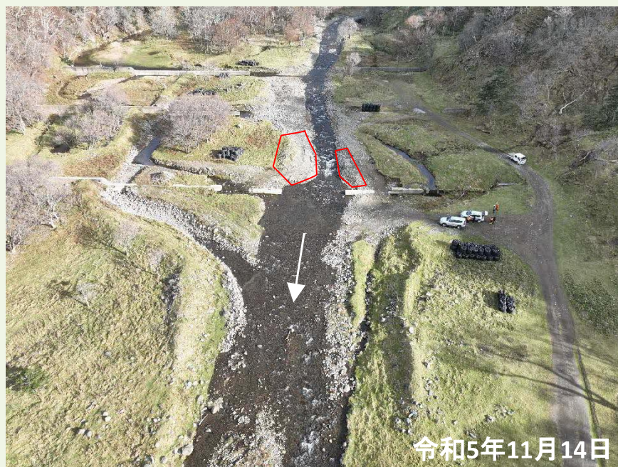
第1ダム－60～第3ダム＋100m地点(下流側から)
