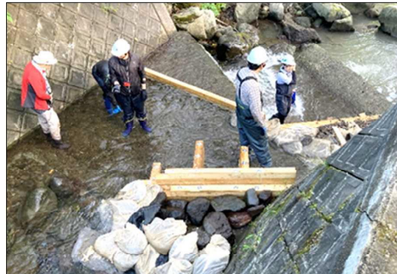
写真3. 盤ノ川簡易魚道の転石はね工
