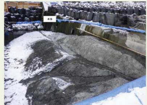
【⑥魚道 基礎コンクリート施工完了状況】
