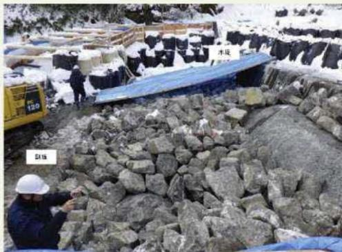
【⑨魚道 間詰コンクリート打設完了状況】
