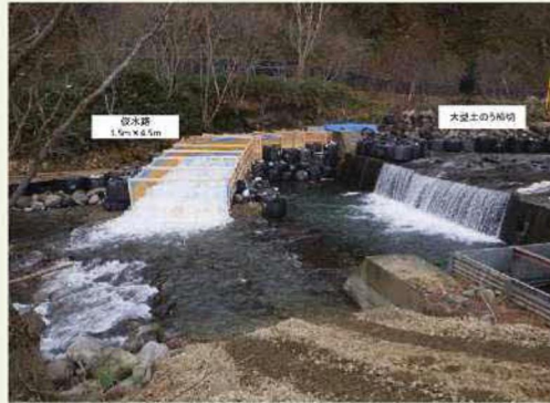
【④魚道 基礎材設置状況】
