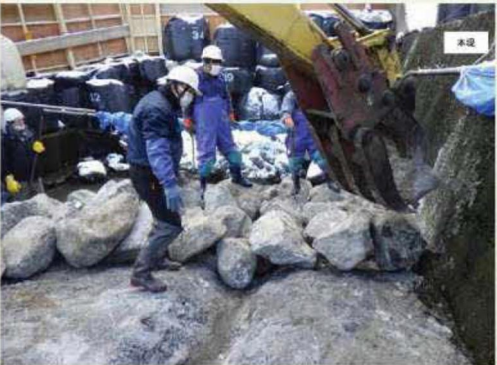
【⑦魚道 石組み施工状況】
