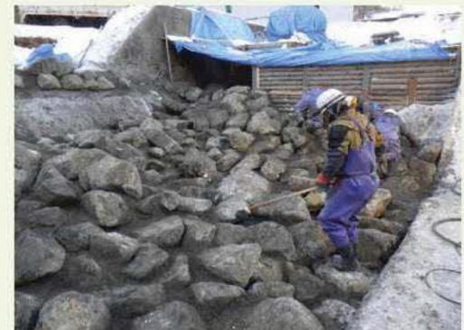
【⑨魚道 間詰コンクリート打設完了状況】
