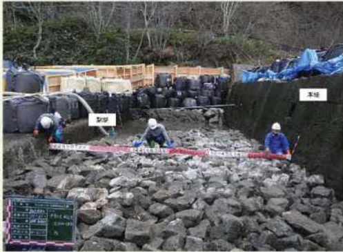
【④魚道 基礎材設置状況】
