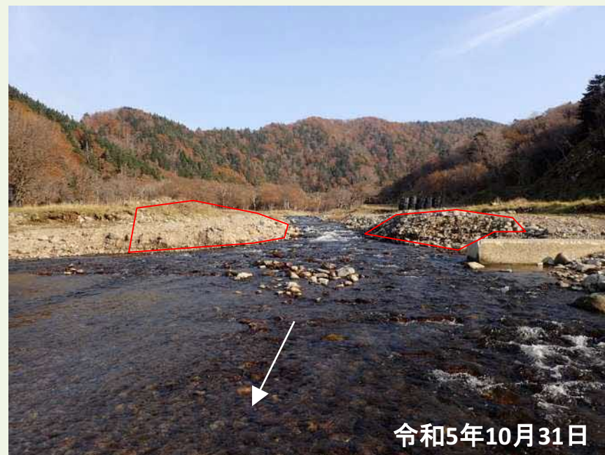
第1ダム＋5～20m地点（下流側から）
