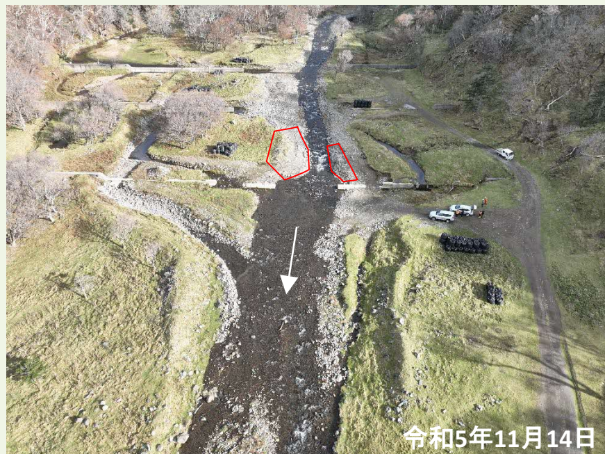
第1ダム－60～第3ダム＋100m地点（下流側から）
