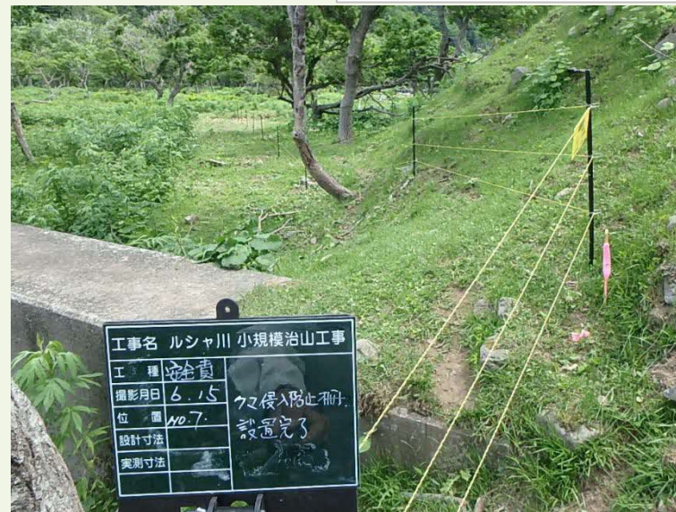
電気柵(工事期間設置)
