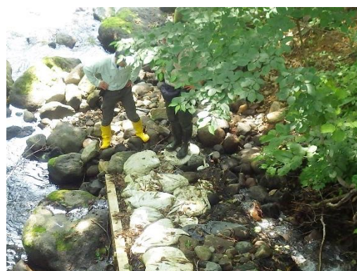
魚道下部で伏流化した状況（2023 年 7 月 23 日）
