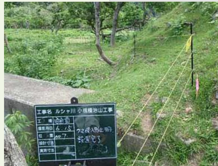
電気牧柵(工事期間設置)
