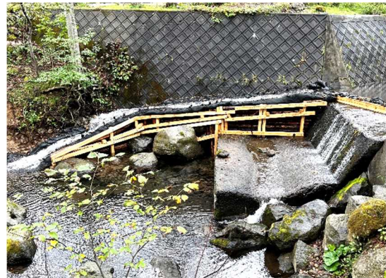
写真 1. 完成直後の盤ノ川簡易魚道
