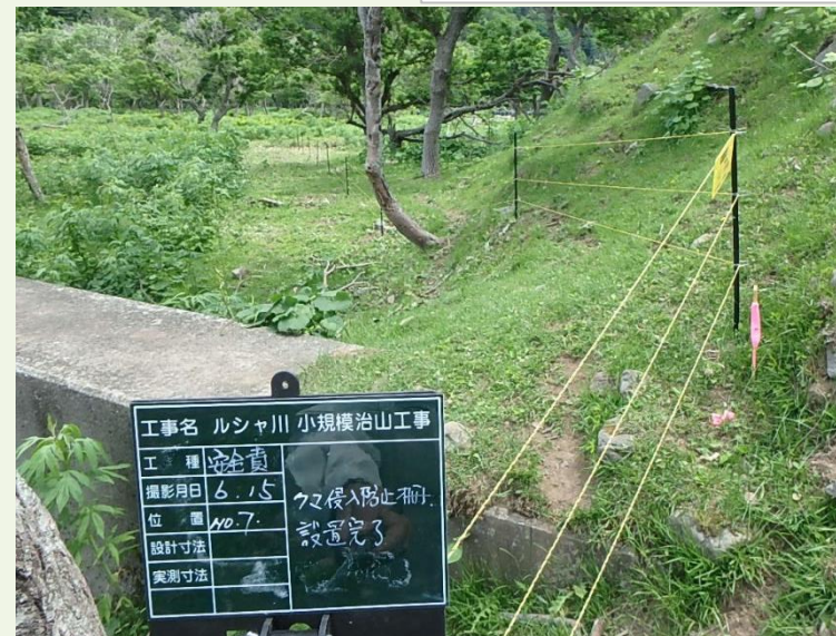
電気柵(工事期間設置)
