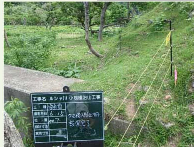
電気牧柵(工事期間設置)
