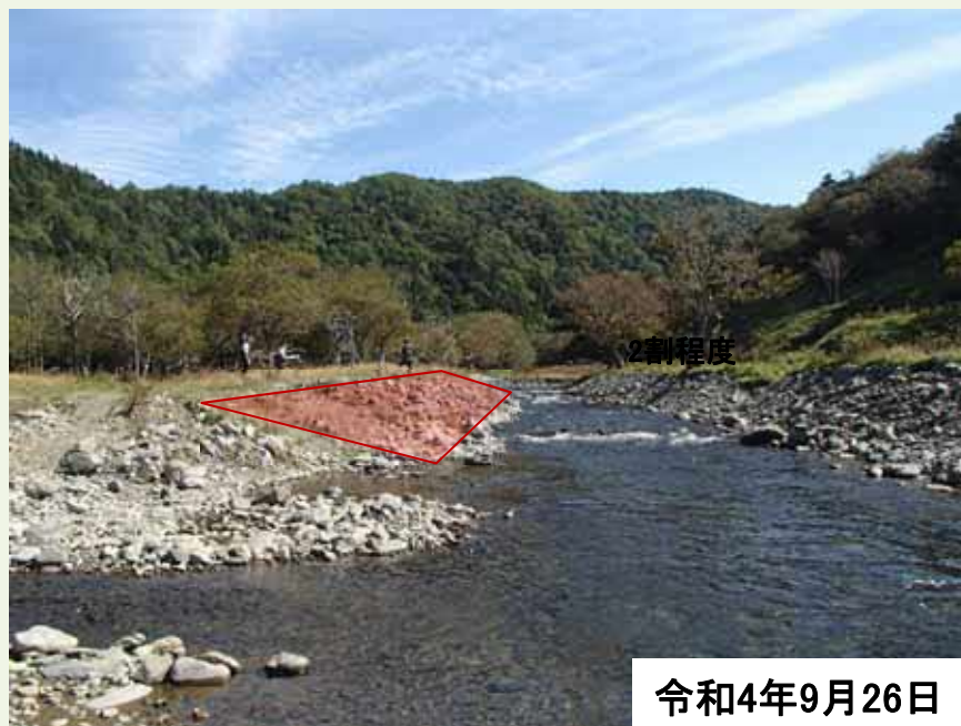
第3ダム＋約80～100m地点(下流側から)
