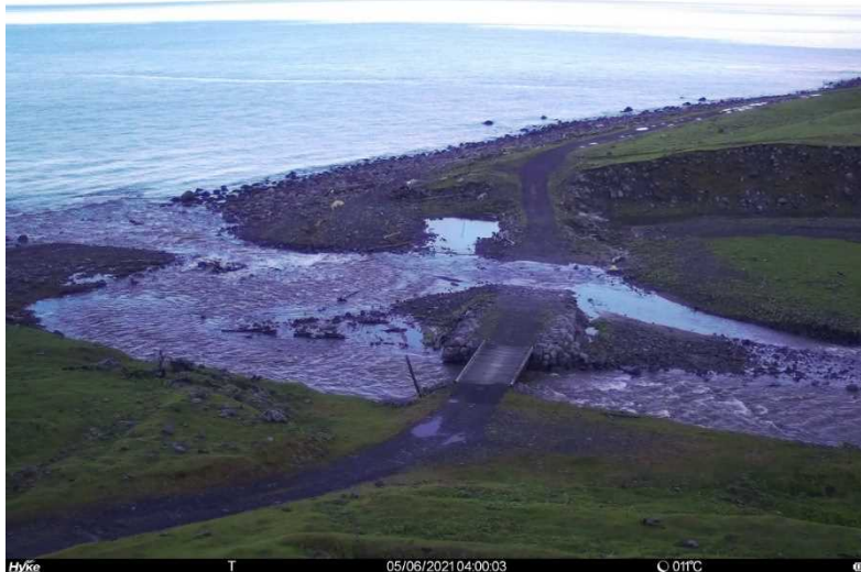
2021年6月5日：増水により河床路を越流
