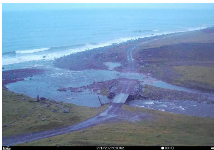
2021年10月21日: 増水により河床路を越流 (9月21日以降、水位計が流出したため流量不明)
