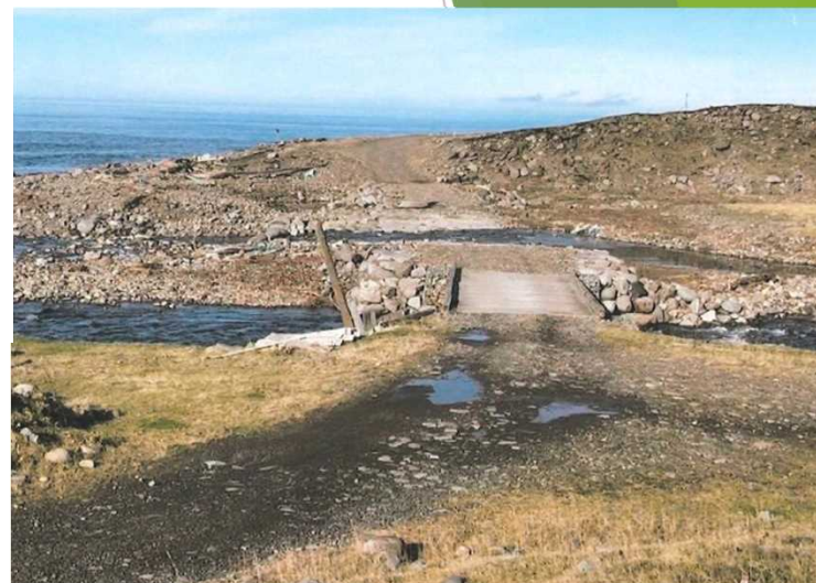
河床路の状況
