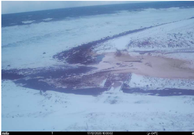
2020年12月17日：波浪により河床路を越流(冬季間に小規模ではあるが数回発生)
