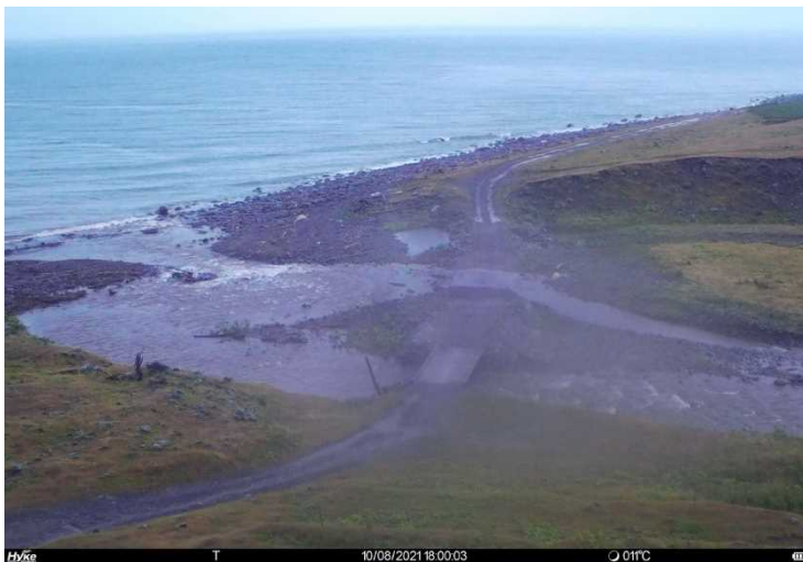
2021年8月10日: 増水により河床路を越流 流量は橋 2.41\text{ m}^3/\text{s} 、河床路 0.86\text{ m}^3/\text{s} と推定
