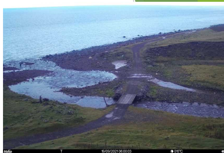
2021年9月18日の夜半に増水により河床路を越流 (写真は9月19日6時) 流量は橋 1.84\text{ m}^3/\text{s} 、河床路 0.49\text{ m}^3/\text{s} と推定
