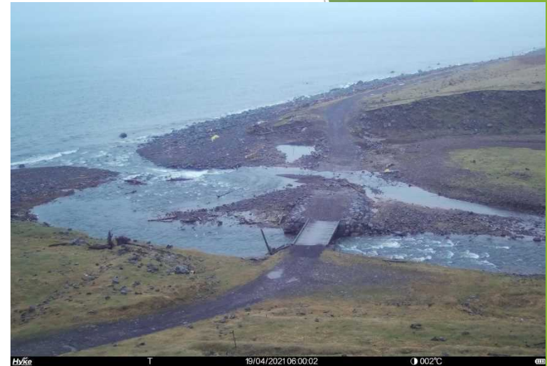
2021年4月19日：増水により河床路を越流
