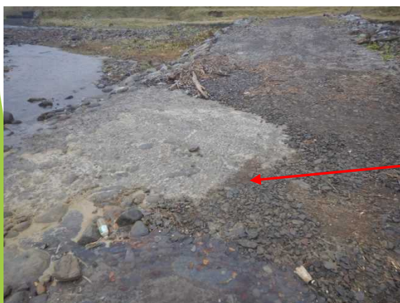
路面間詰の状況
