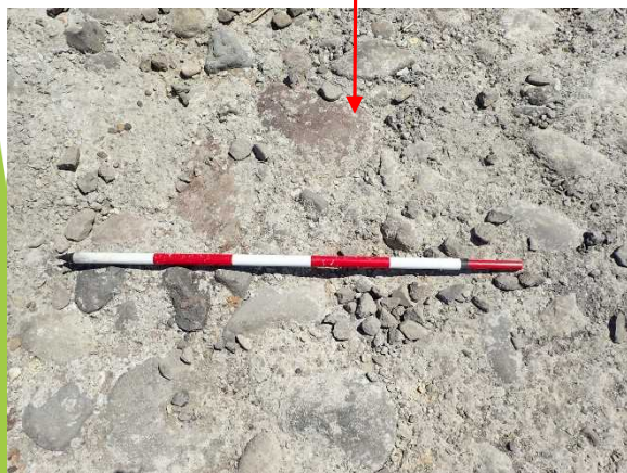
路面間詰の状況
