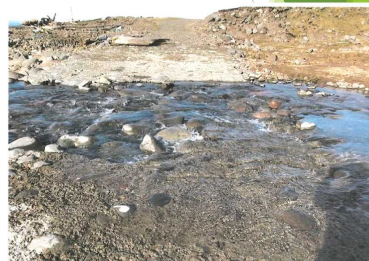
河床路の路面状況
