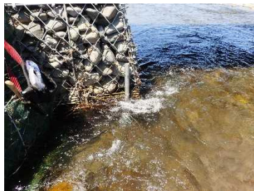
①橋脚左岸上流部の水位計設置箇所 (R3/6/24~9/21) 【9/21に外れて流下したため9/21に観測終了】
