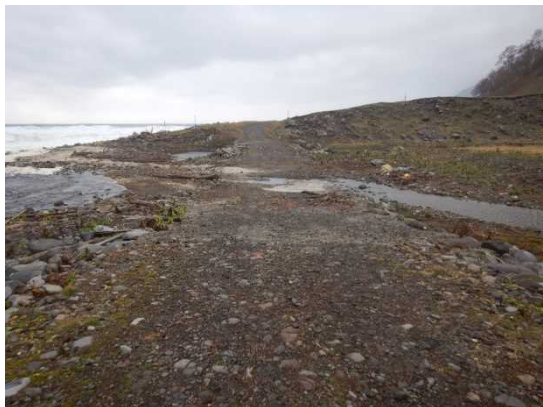
③方向から見た 河床路
