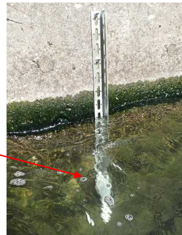
水位計設置箇所
