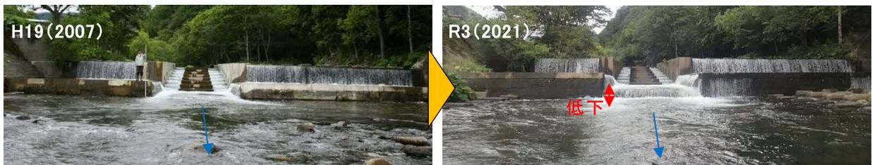
写真 2 河床低下の兆候が見られる構造物の例 (14号床止工)
