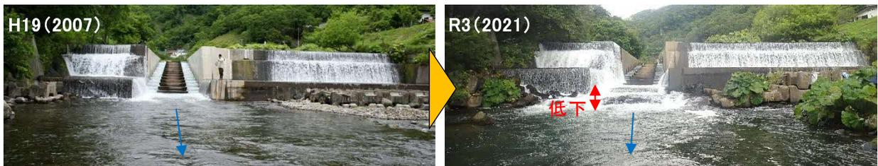
写真 1 河床低下の兆候が見られる構造物の例 (6号床止工)
