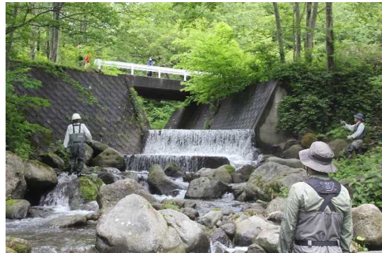
写真 1. 盤ノ川橋脚（勝利橋）と落差工
