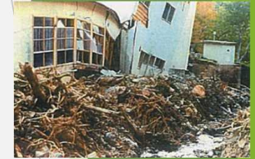
昭和56年災害 ホテルの被害状況
