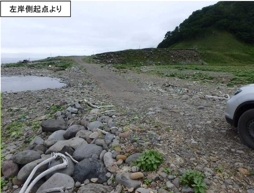
○河床路の縦断及び横断測量、目視による確認を行った結果、路体の変状等は確認されなかった。
