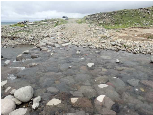
通水後の路盤状況
