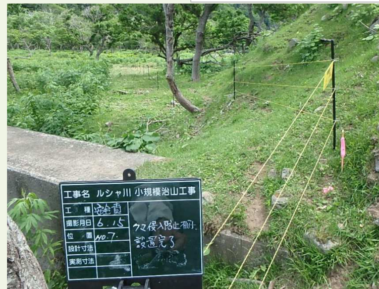
電気柵(工事期間設置)
