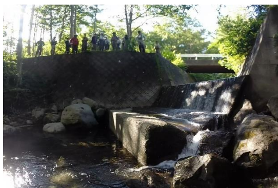
図 10. 改修の検討対象となった盤ノ川橋脚下落差を視察する河川 AP 委員。(2019 年 7 月 17 日)
