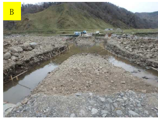
B 掘削完了
