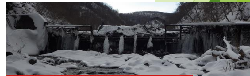
平成30年度 工事完了(H30.12.14撮影)
