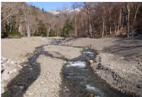
図 13. 改修後2年が経過したピリカベツ川 工物(上流側)(2009年5月)
