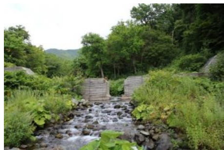
図 16 改修後10年が経過した同地点 (下流側)(2017年8月)
