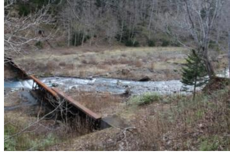
図 20. 改修後 8 年が経過した同地点 (2018年11月)
