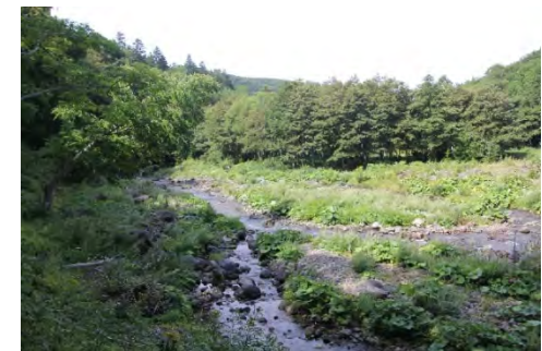
実施後2 (2年経過) 2015年8月26日
