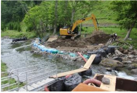
図 11. 岩尾別ふ化場の取水口改修の様子 (2018年6月)
