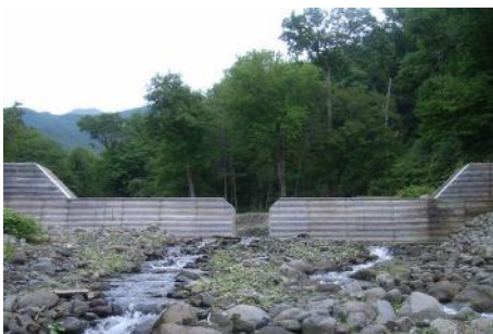
図 15 改修後3年が経過したピリカベツ川 工物(下流側)(2010年8月)
