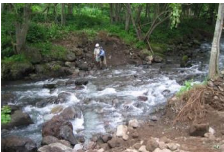
図 17 直後の赤イ川ふ化場導水管工物 (2008年8月)
