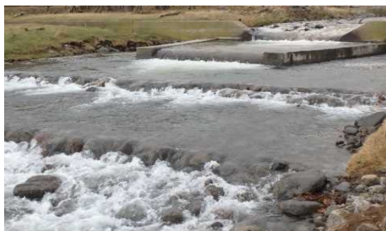
写真1 H28年(2016)石組落差解消
