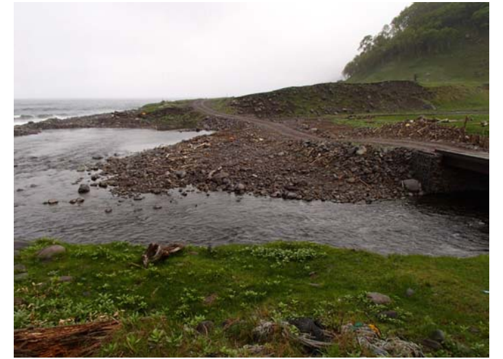
04 橋の下流右岸の状況(左岸より望む)
