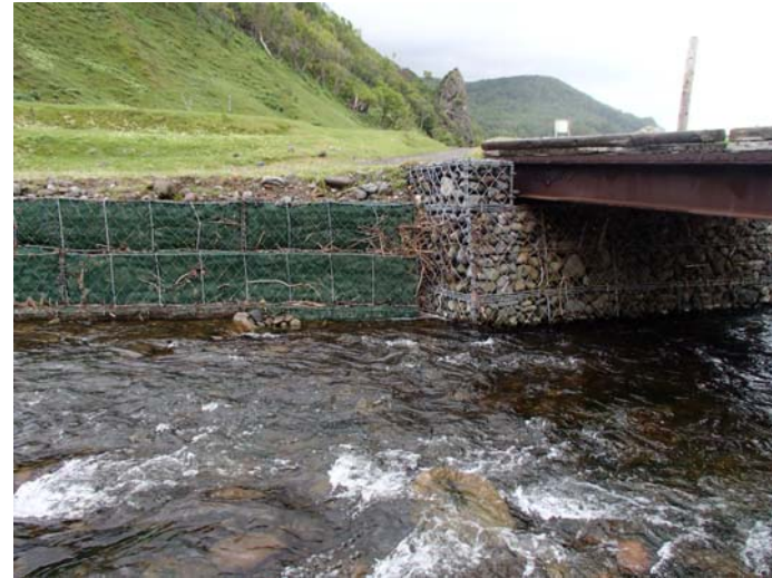
06 橋の上流左岸の状況
