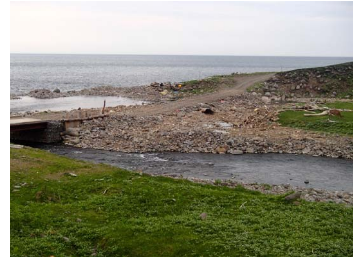
08 橋の上流右岸の状況(左岸より望む)
