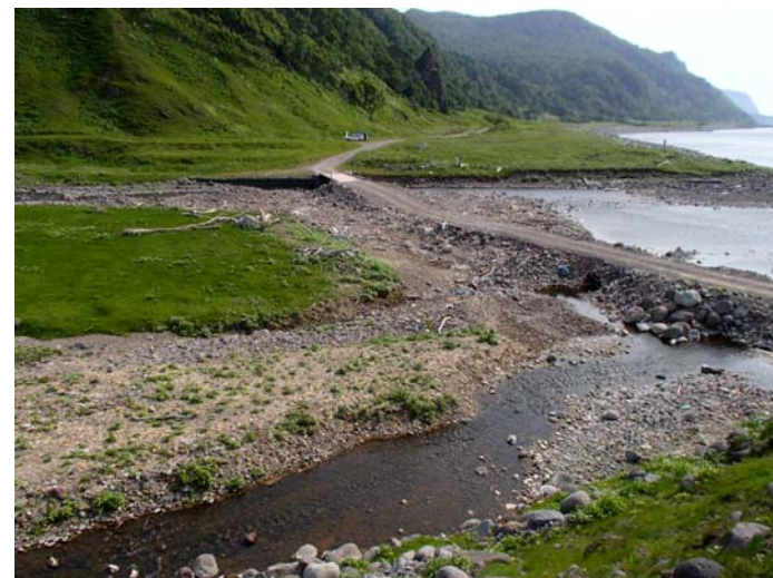
11 道の上流側(山側)の状況(右岸高台より望む)
