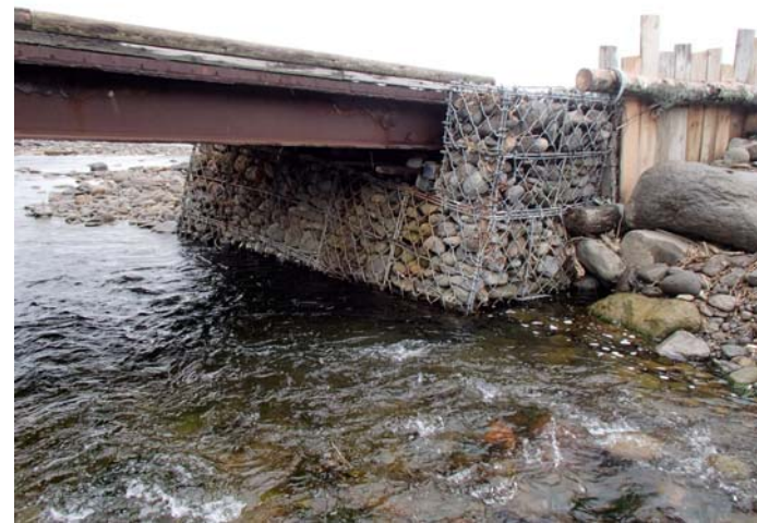
07 橋の上流右岸の状況
