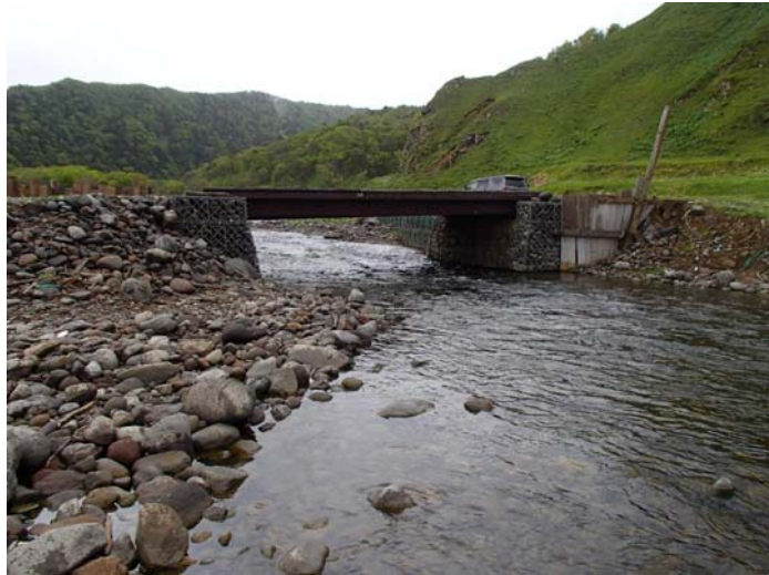
05 橋の下流右岸より橋を望む
