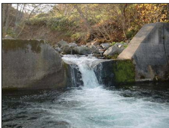
複断面放水路内
