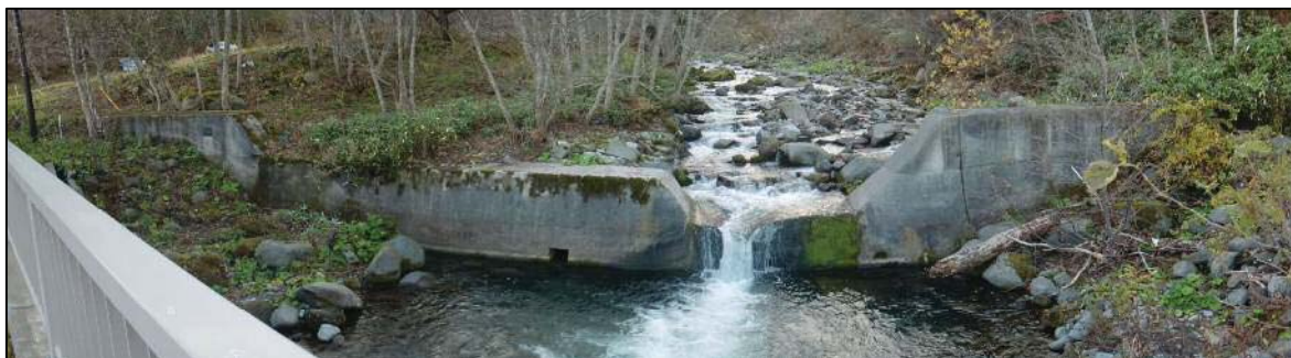
NO.1 床固工 (昭和54年度施工)
