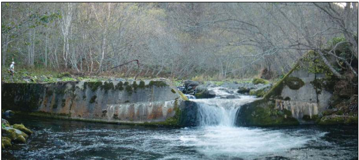
NO.2 床固工（昭和 50 年度施工）
