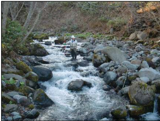
NO.1 床固工上流部の溪床
