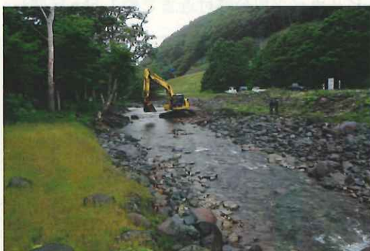
写真1. 重機を用いた岩石の配置（2012年7月）
