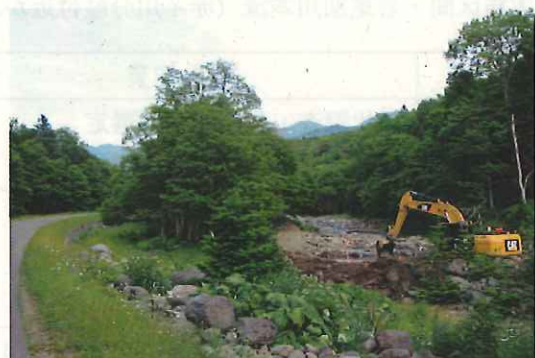
写真2. 重機を用いた土手の敷均し（2014年7月）
