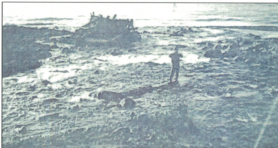
1973年10月 漁場の捕獲施設や木橋倒壊の被害状況 (写真-2)
