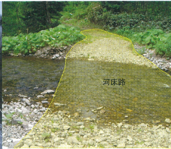
河床を整理しただけだと洪水時に河床が掘られ常に整備
