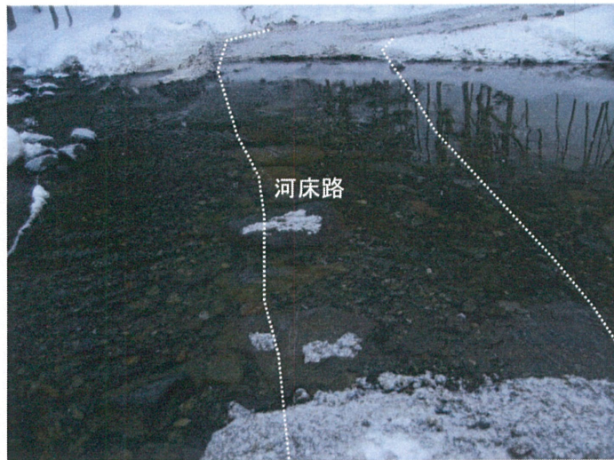
大石を置いただけでは大石の隙間の礫が流出される
