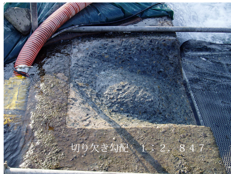
ルシャ川の切り欠き施工例
