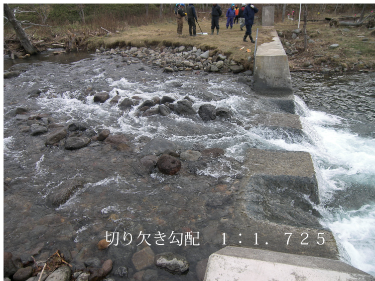
ルシャ川の切り欠き施工例
