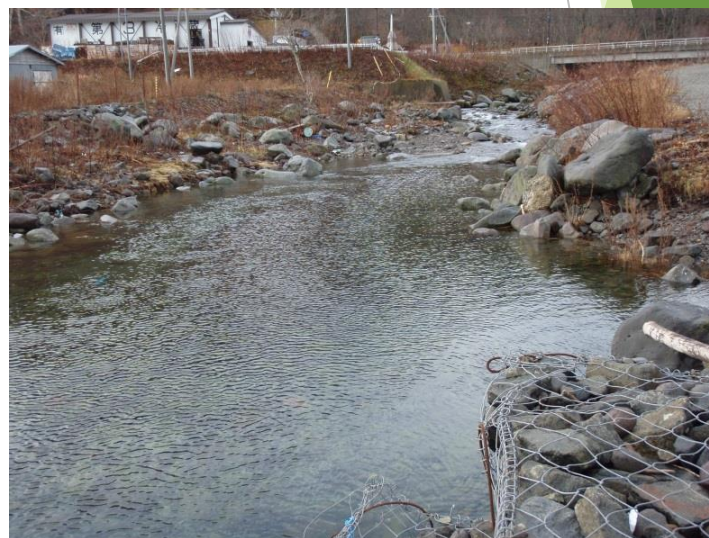
第1ダム下流側
