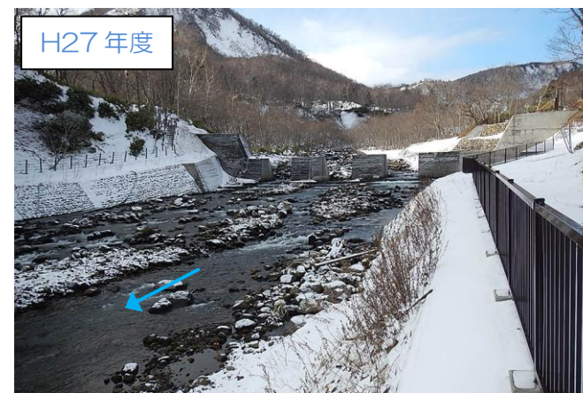
特別緊急砂防堰堤魚道およびスリットの状況 [左：⑦2014年(H26)_9月 中：⑧2015年(H27)_10月 右：⑨2015年(H27)_12月]
