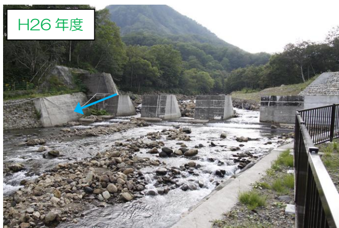
特別緊急砂防堰堤魚道およびスリットの状況 [左：⑦2014年(H26)_9月 中：⑧2015年(H27)_10月 右：⑨2015年(H27)_12月]
