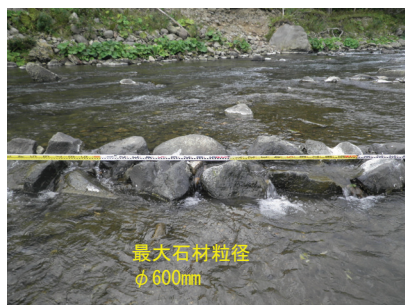
第5号床止工上流石組み帯工（空）
