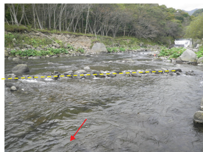
第5号床止工上流石組み帯工（空）
