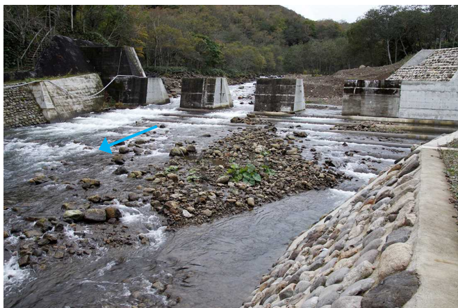
特別緊急砂防堰堤魚道およびスリットの状況 [左：⑦2013 年(H25)_10 月 中：⑧2014 年(H26)_1 月 右：⑨2014 年(H26)_12 月]
