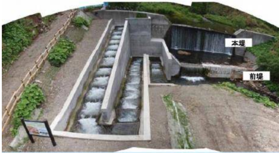
第1 治山ダム 改良後
