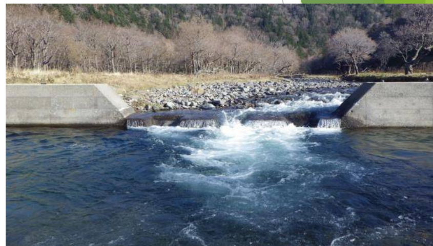
第3ダム（平成18年改良後）
