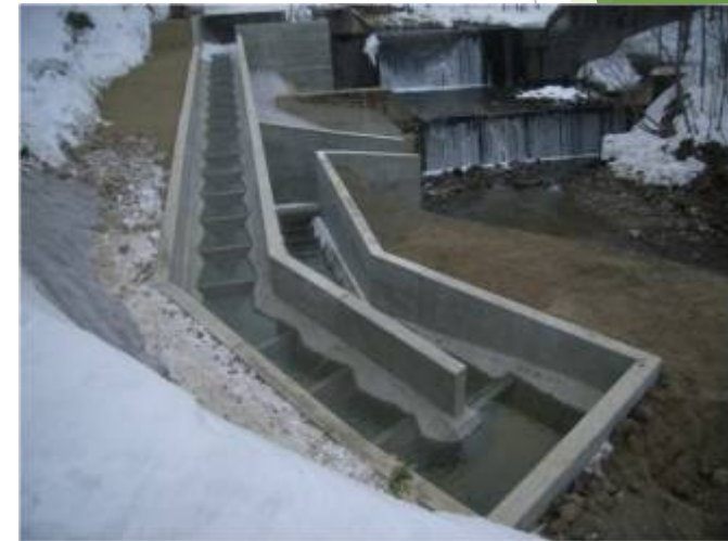
第2 治山ダム 改良後
