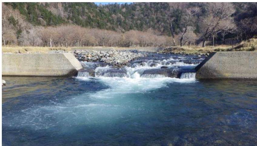
第2ダム（平成18年改良後）
