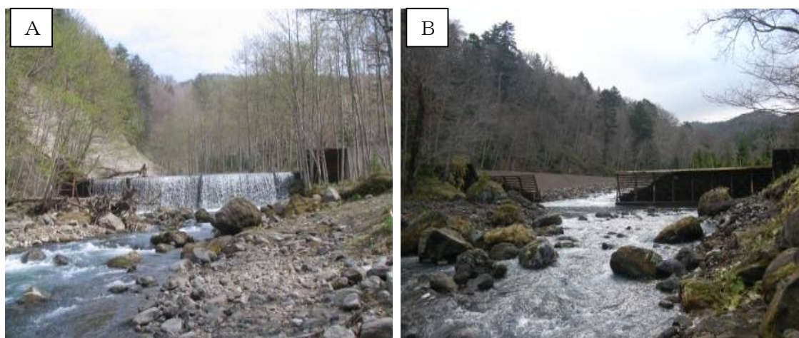
図 6. ダム改良前後（スリット化） A：改良前、B：改良後
