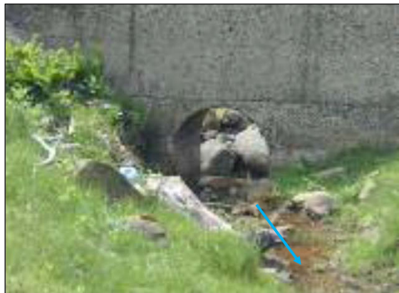
NO1床固工 右岸下流
