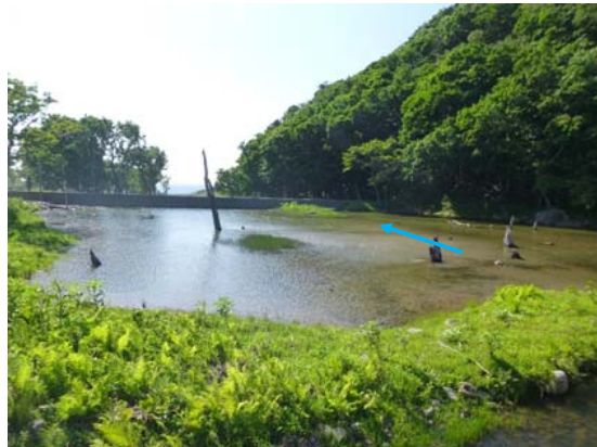
NO2床固工 右岸上流
