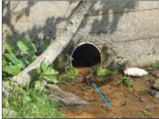
NO2床固工 右岸下流
