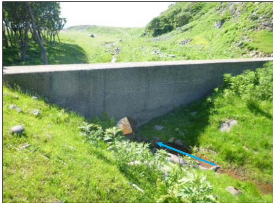
NO1床固工 右岸上流
