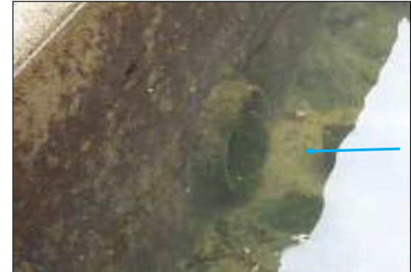
NO3床固工 右岸上流
