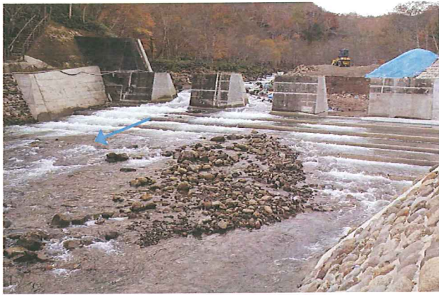
特別緊急砂防堰堤魚道およびスリットの状況 [左：⑦2012(H24)_11月 右：⑧2013(H25)_10月 右：⑨2014(H26)_1月]
