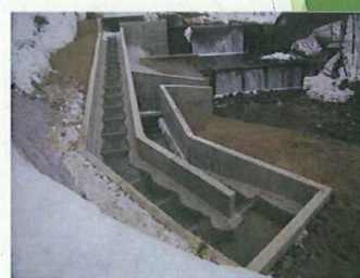
第2 治山ダム 改良後
