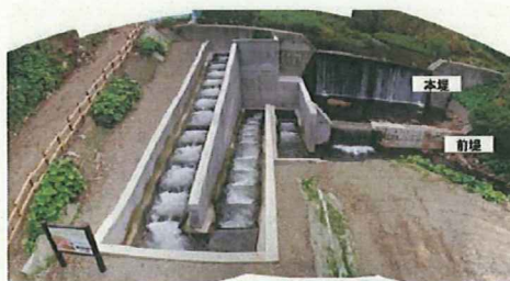
第1 治山ダム 改良後
