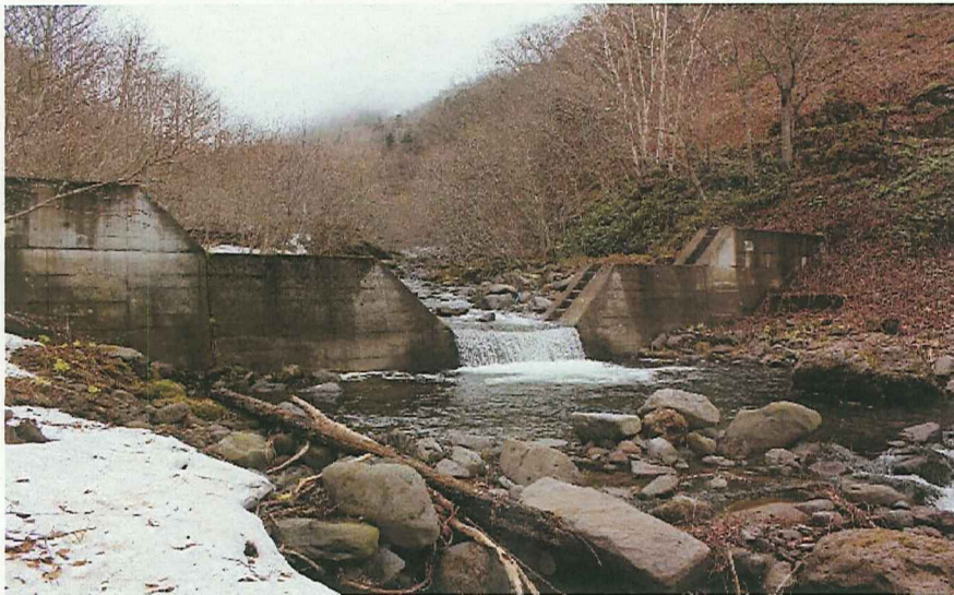
No. 6 床固工 (平成4年施工)
