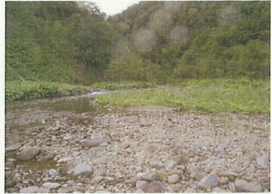
治山ダム上流の土砂堆砂状況。
