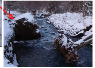
№12改良ダム上流の石張法面 の左岸が大きく侵食され倒木が 発生(H25/12/24)
