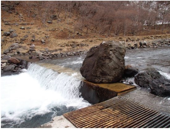
捕獲場えん堤上に流下・堆積した 巨石(φ1.6m)(H25/12/3)
