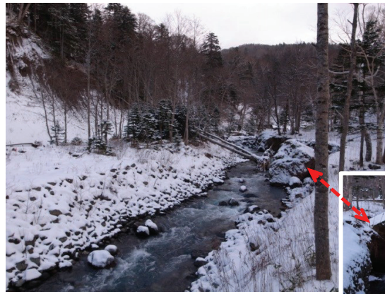
№12改良ダム上流の石張法面 の左岸が大きく侵食され倒木が 発生(H25/12/24)
