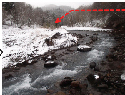
№13改良ダム上流(H25/12/3) 堆積部が侵食され流路が右岸寄 りになる。
