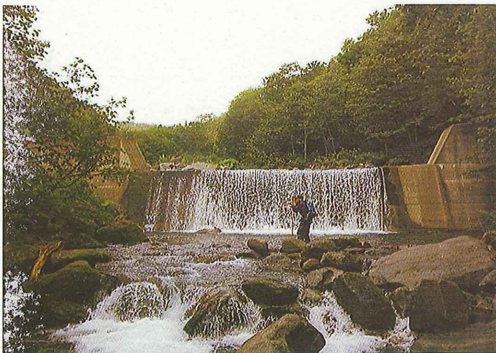
国有林 No.1 谷止工(昭和62年度 1987年度施工)
