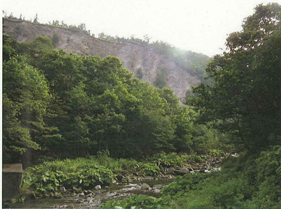
国有林 No.4 床固工上流部の大崩壊地の状況
