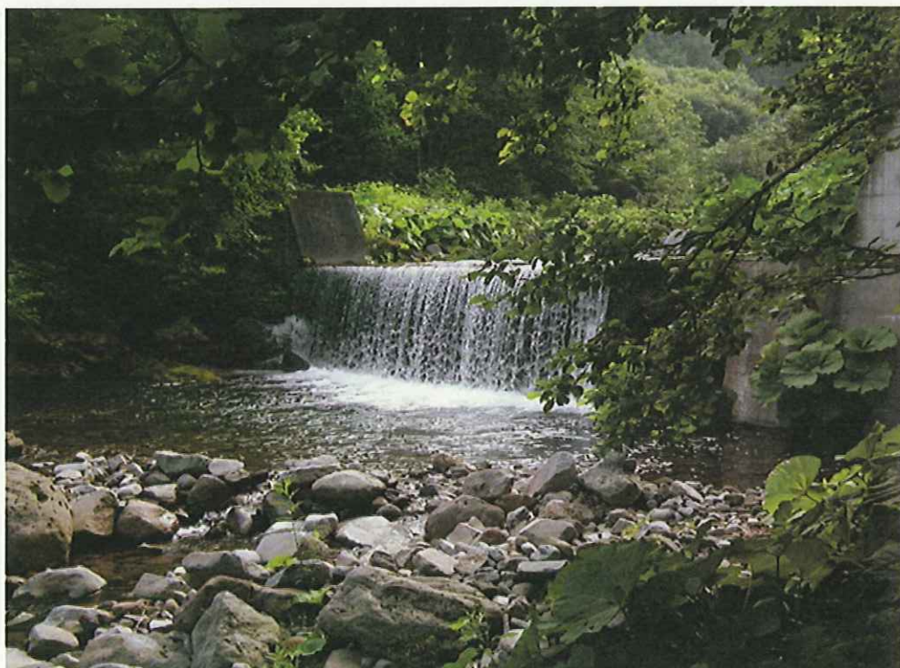
国有林 No.4 床固工(平成2年度 1990年度施工)
