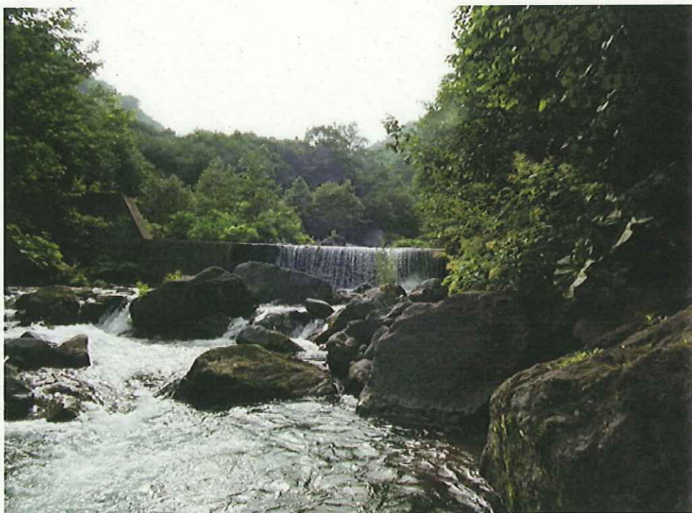
国有林 No.2 谷止工(昭和63年 1988年度施工)
