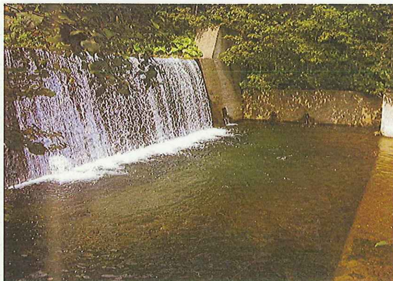
国有林 No.5 副ダム上流部のプールの状況
