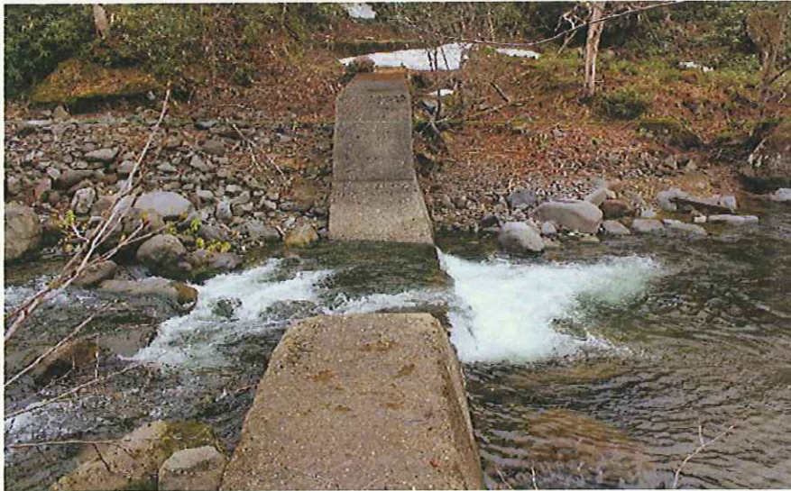
No. 5床固工 (昭和53年施工)
