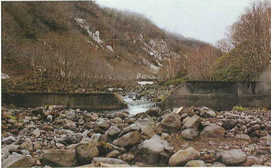
No. 4 床固工 (昭和52年施工)
