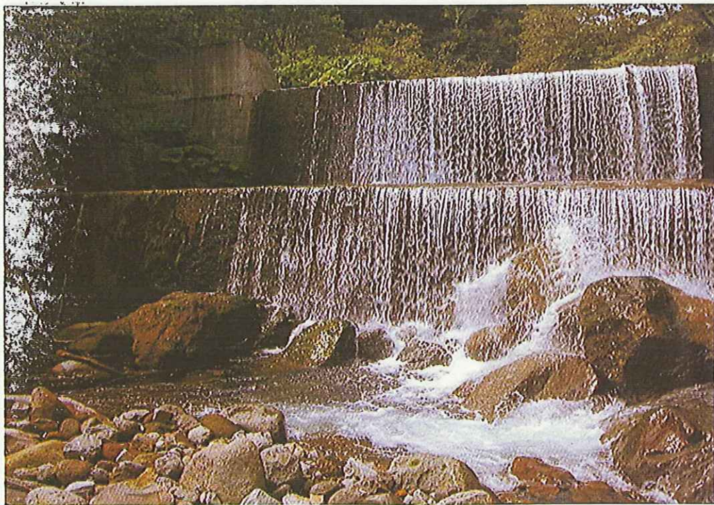
国有林 No.6 谷止工(昭和60年度 1985年度施工)
