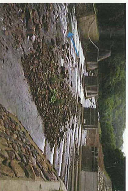
特別緊急砂防堰堤魚道およびスリットの状況 [左：⑤2012(H24)_11月 右：⑥2013(H25)_8月]
