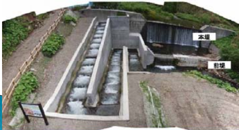
第1 治山ダム 改良後
