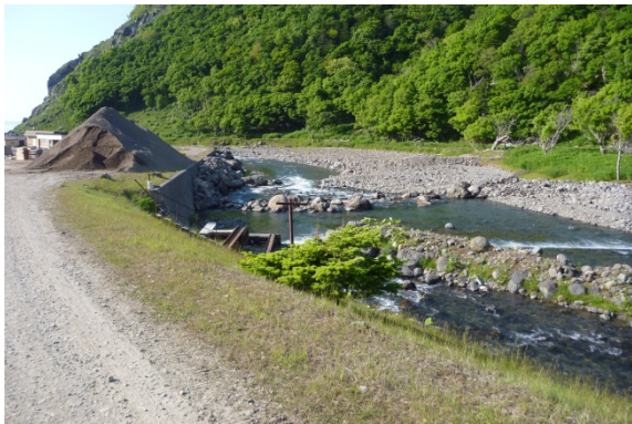
作業後の取水口周辺の様子（「区画1-C」）。
